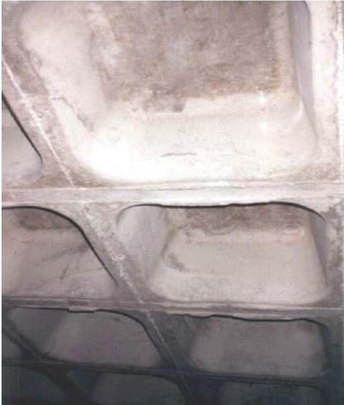
O tecto e o seu comportamento acústico torna-se num ponto crucial para as condições de trabalho destas instalações, tecto este que, neste caso, consistia numa laje de cocos de betão, material extremamente reverberante, pouco estético, desconfortável e mal acabado.
